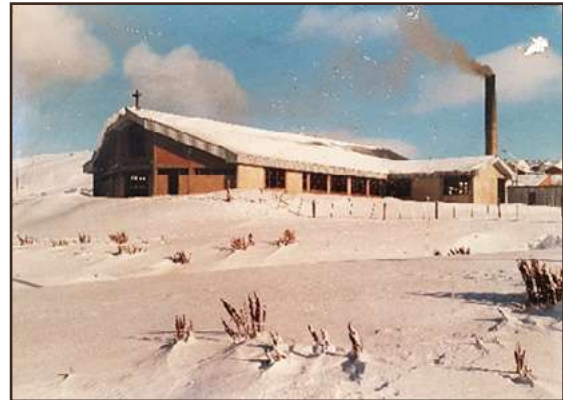
Figura 1. Fotografía de la iglesia Santa María de la Paz en estado de obra avanzada. Gentileza: P. César Heltner.
